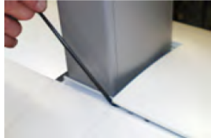
2) Hacer palanca para extraer las tapas superiores a ambos lados de la columna.
