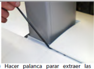
2) Hacer palanca para extraer las tapas superiores a ambos lados de la columna.
